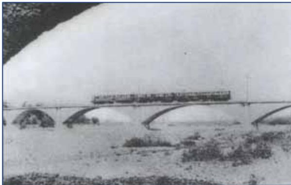
pochissimi manufatti ferroviari in curva da 300 metri di raggio ed in salita del 15 per mille, con cinque campate da 40 metri ciascuna.
