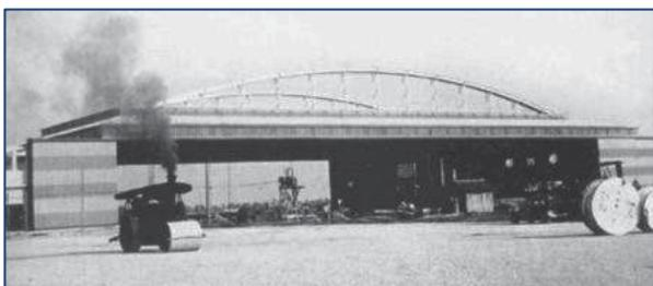
dimensioni notevoli ad unica campata sostenuta da due travature metalliche paraboliche di 235 metri di ampiezza e di 64 metri di profondità con apertura totale mediante portali in ferro scorrevoli e sovrapponibili. Ai lati dell’hangar vengono sistemati i magazzini delle parti di ricambio, l’officina, gli alloggi e la mensa del personale militare, nonché gli uffici per le aviolinee.
