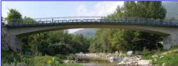
costante pari a 50cm, sostiene la soletta di 12cm di spessore attraverso due muretti laterali di sp.30cm. Le spalle pure a sezione scatolare, con due pareti di 90 cm lunghe 5,50mt, la soletta superiore di sp.12cm e quella di base sp.20cm che appoggia sulla platea di fondazione.
