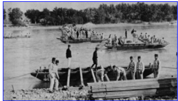
Nel mezzo della prima barca EF dirige la costruzione di un ponte di barche
