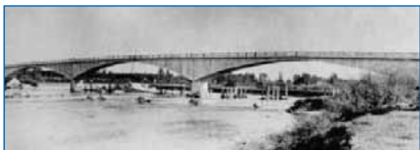
Il ponte di Chatel de Neuvre (1914-1923) ed il disarmo "automatico"
