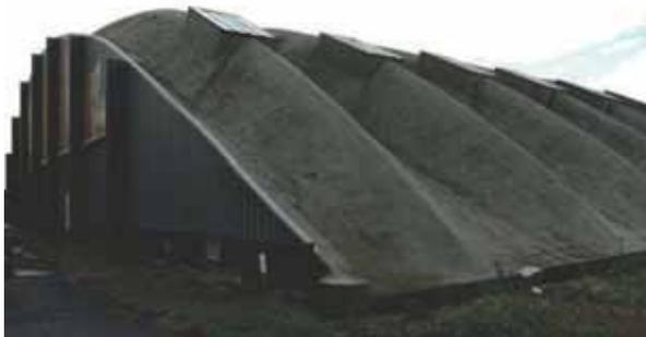
**L'hangar n.18 nella base 112 di Orléans Bricy et Loisir Marne Courcy, a Reims del 1931-32** è un edificio dalla forma insolita che attrae ancora l'attenzione per l'originalità della copertura costituita da sottili volte in cemento armato con i tiranti nascosti nello spessore della soletta che forma la zona inferiore. Volte di 60 mt di luce di 5cm di spessore, conoidi accoppiati a V.
