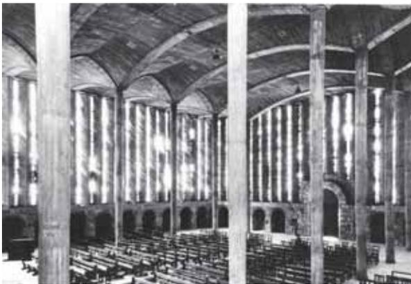
In collaborazione con l'arch. Pierre Pinsard, progetta nel 1954-55, il convento dei Domenicani a Lille, dove la cappella è coperta da un'armoniosa struttura ondulata, un guscio sottile di C.A. a doppia curvatura.
