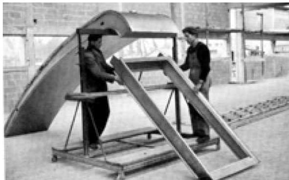
Il completamento ed il montaggio dell'elemento di copertura è stato notevolmente semplificato, poiché consiste di poche parti: due travi di supporto di acciaio stampato, collegate da traverse metalliche, e coperto con un foglio di alluminio sia all'esterno che all'interno, ed una cornice di acciaio stampato in cui il vetro può essere montato. La larghezza dell'elemento varia da 3 a 8 metri. Lo shed
