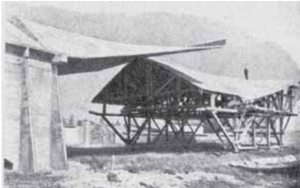
E' infatti ancora l'impresa Rouzard e figli di Parigi che gli offre l'opportunità di costruire una struttura sperimentale in cemento armato, con superfici sghembe, per poterne verificare le deformazioni sotto l'effetto dei carichi. L'idea è quella di un elemento per hangar sul tipo di quello di Albert Caquot, direttore tecnico del Ministero dell'aria, in struttura metallica, in corso di costruzione a Orléans Bricy (1932-33).
