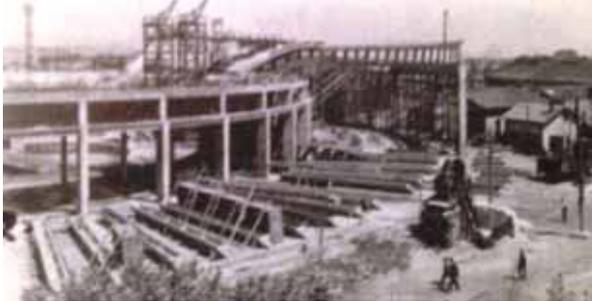
Le facciate sono con travi V Laffaille con le punte verso l'esterno, con grandi vetrate alte 15 metri, che rendono una idea di leggerezza con l'impiego della minima quantità di materiale. Prefabbricate a terra e sollevate con un semplice paranco, hanno permesso di costruire la rotonda nel tempo record
