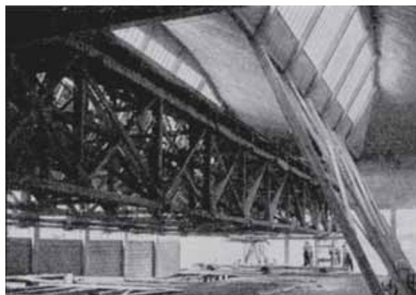
Nel 1933 Laffaille costruisce il primo esempio di una struttura a forma di paraboloidi iperbolici<sup>4</sup> in cemento armato a Dreux, nel cantiere dell'impresa Rouzard, al fine di validare la sua teoria generale delle superfici a doppia curvatura.
