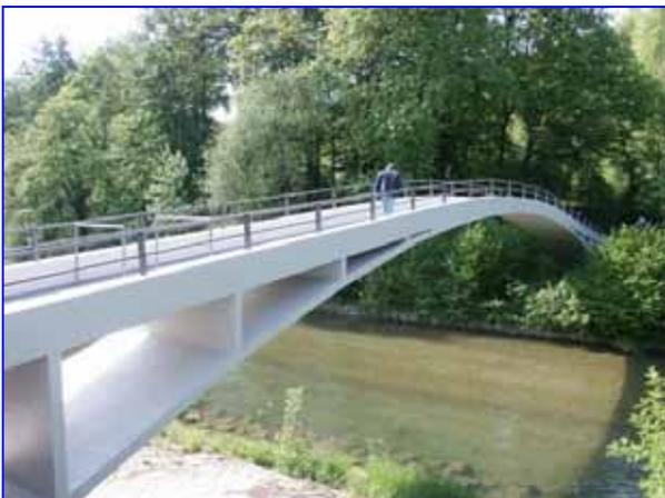
la soletta con il parapetto. L'arco e la soletta lavorano insieme in una struttura leggera e rigida ed in più il parapetto in C.A. non è una massa
