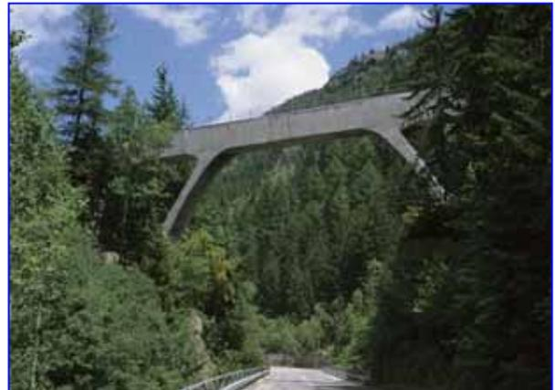
**Grand Fey** (1926) E' questo un viadotto ferroviario da ricostruire nella stessa posizione e senza interrompere il traffico ferroviario: una grande opera di "sostruzione" che RM risolve brillantemente con un insieme di archi sovrapposti a coprire le 6 campate per una luce totale di 383 metri.
