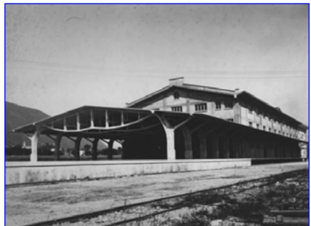
riduzione del materiale da impiegare, attraverso l'uso di archi cavi e pareti molto sottili. Brevetta
