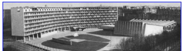
costituita da una lamina plissettata, intersecata da una soletta, che passa dal lembo inferiore agli appoggi a quello superiore in mezz'opera, con un
