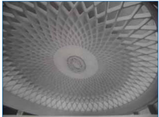
delle Terme di Chianciano (1952), dove l'intensità della luce si gradua col progressivo allargarsi del reticolo delle nervature verso l'esterno, e a quella piana del lanificio Gatti di Roma (1952), dove le nervature dei solai, che seguono l'andamento dei momenti principali, sono efficacemente valorizzate dalla luce radente. Particolari ed interessanti i due edifici per magazzini del sale realizzati a Tortona (1950) per conto dei Monopoli
