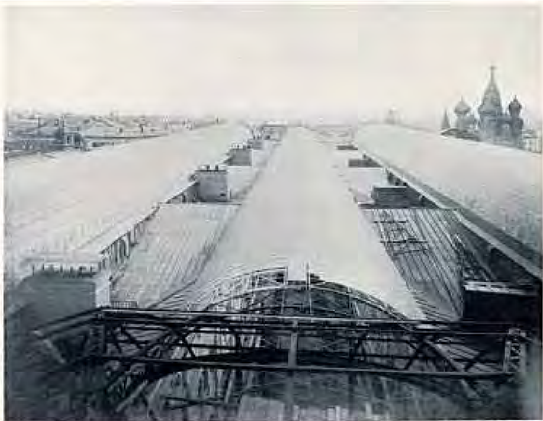
NOUVELLE GALERIE. TRAVAIL EN COURS
