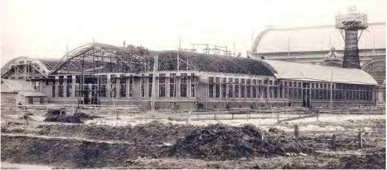
Sullo sfondo la torre in costruzione
