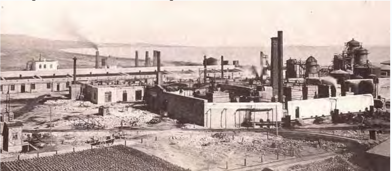
1889-90 Apparato per la distillazione del petrolio grezzo; patnership tra AV.Bari e SM Shibaev, a Baku. Ogni unità lavora oltre 15.000 ton. al giorno.
