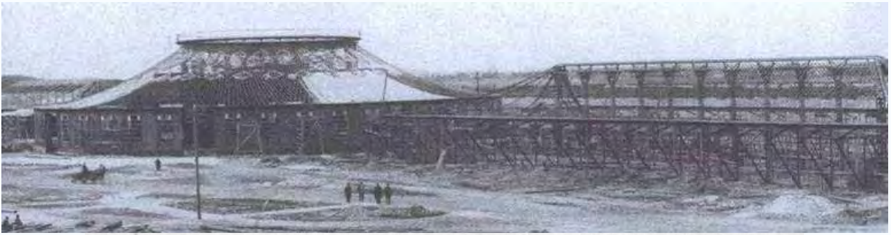
La rotonda e l'adiacente edificio a pianta rettangolare
